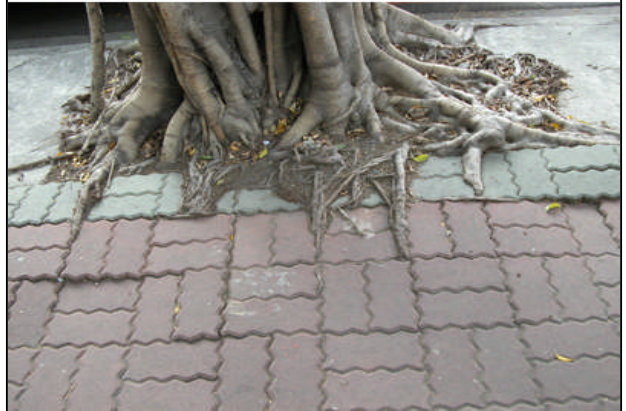
圖 4：根系會穿入連鎖磚之縫隙中
