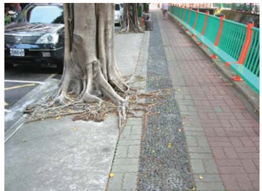
圖 11. 大容東、西街的垂榕地表根盤踞鋪面
