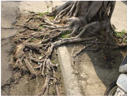
圖 16. 垂榕地表根直接從窄小植穴蔓生至車道
