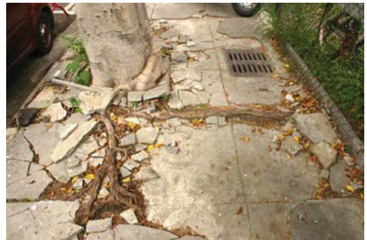
圖 17. 根將水泥鋪面弄得破碎不堪
