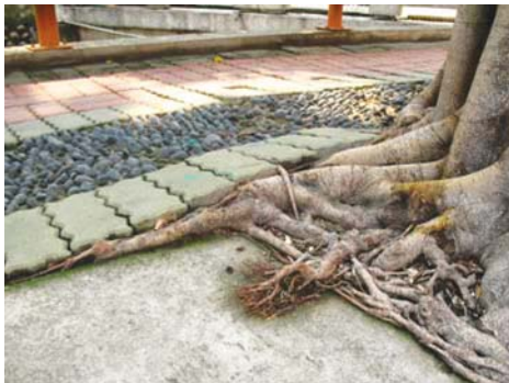
圖 4. 根系造成連鎖磚鋪面高突
