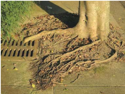
圖 12. 垂榕根系鑽入排水溝
