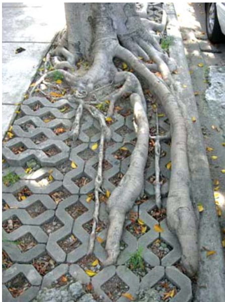
圖 1. 地表根鑽入連鎖磚縫隙向下入地生長
