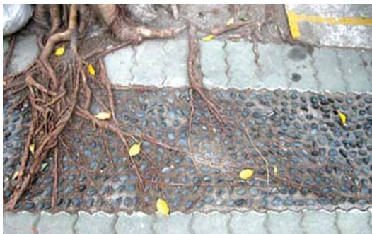
圖 7. 根群於洗石子鋪面石粒間凹陷處亂竄
